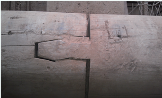
图1 稜恩门上的正心桁
