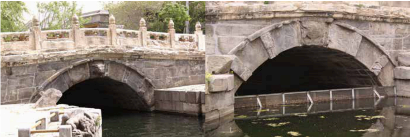
图一三 拱券结构现状
