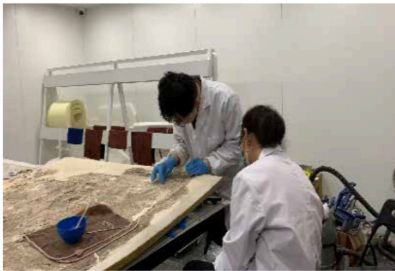
图一八 壁画右下角破碎地仗层错位块修补
