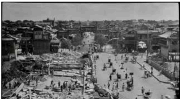
图一〇 正阳桥加宽改造中
