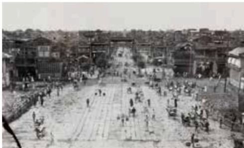
图九 正阳桥（拍摄于1919年改造前）
