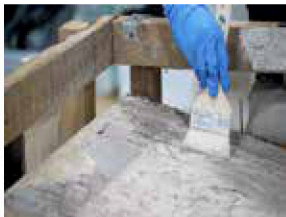
图一〇 人工物理除尘除污操作
