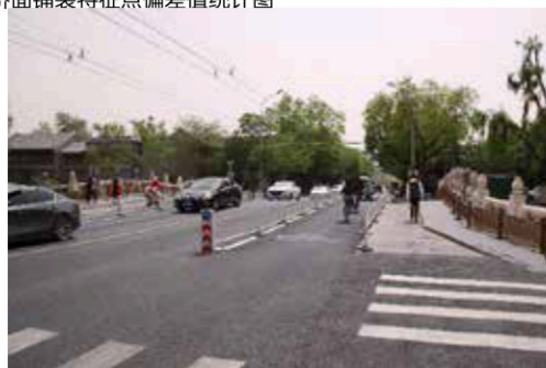
图二四 桥面铺装现状
