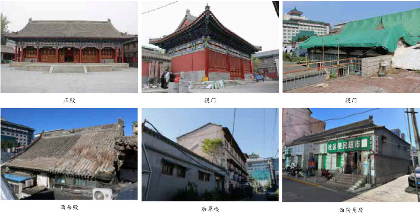
图四 王府各建筑现状照片
