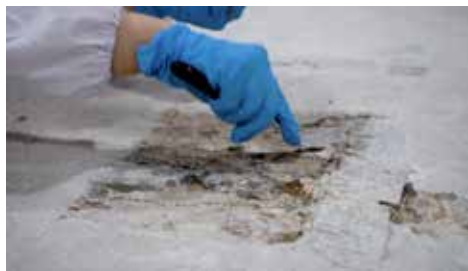
图一五 清理减薄地仗层
