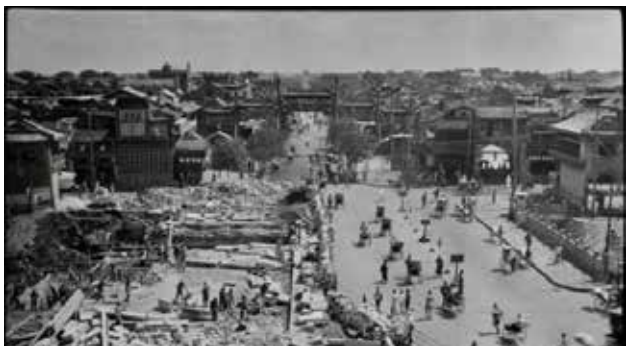
图一〇 正阳桥加宽改造中
