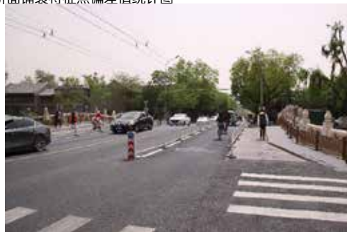
图二四 桥面铺装现状
