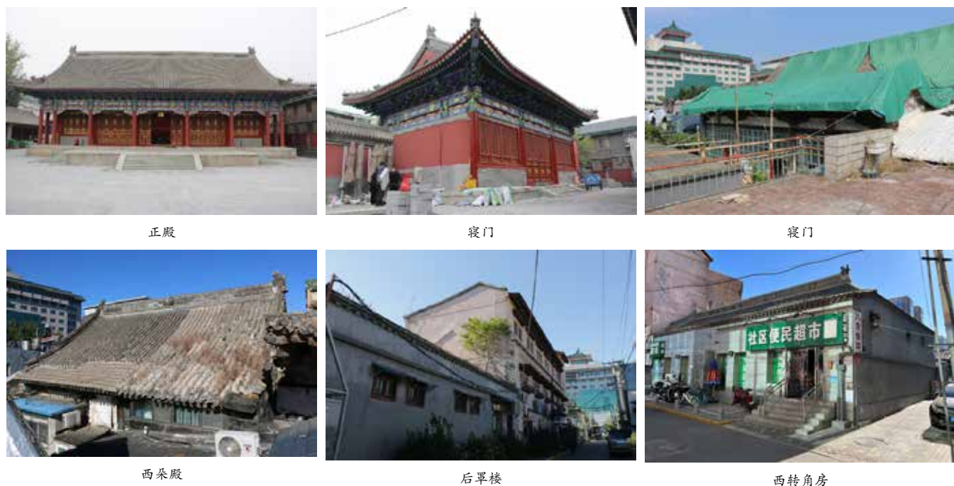
图四 王府各建筑现状照片
