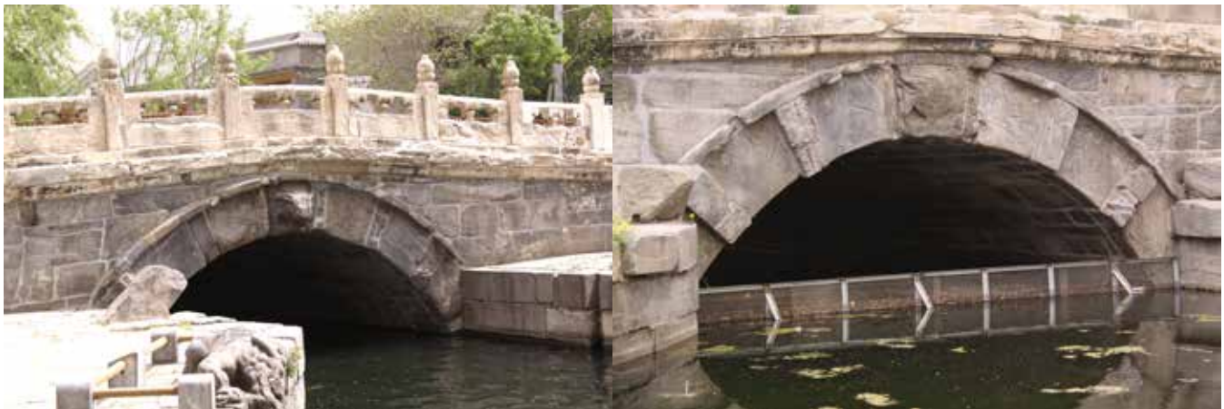
图一三 拱券结构现状
