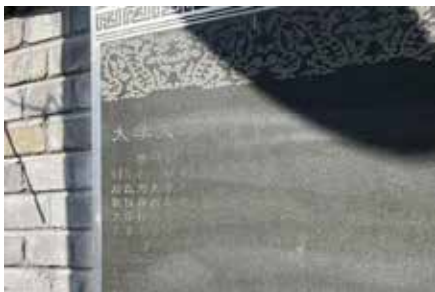
图八 某文物点标识牌严重磨损字迹漫漶不清
