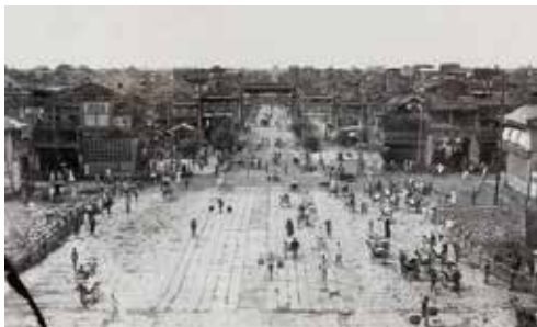
图九 正阳桥（拍摄于1919年改造前）
