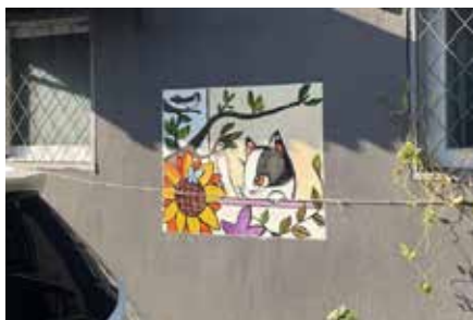
图一一 某街区墙绘缺乏与街区风貌的文化联结
