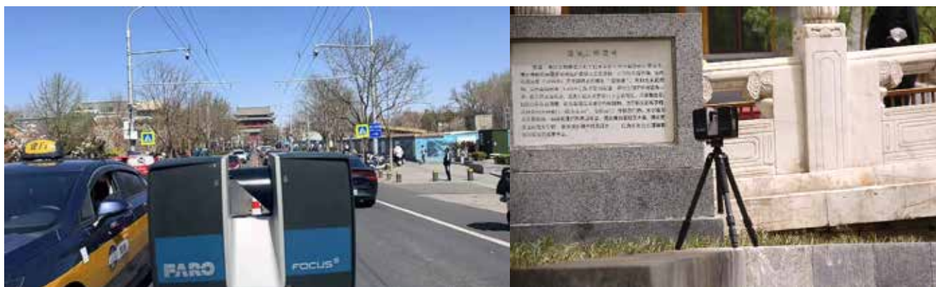
图五 三维激光扫描现场
