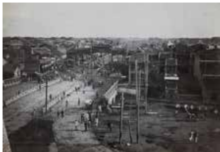
图八 正阳桥（拍摄于1912—1914年间）
