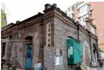
图四 改造前的清华园车站
