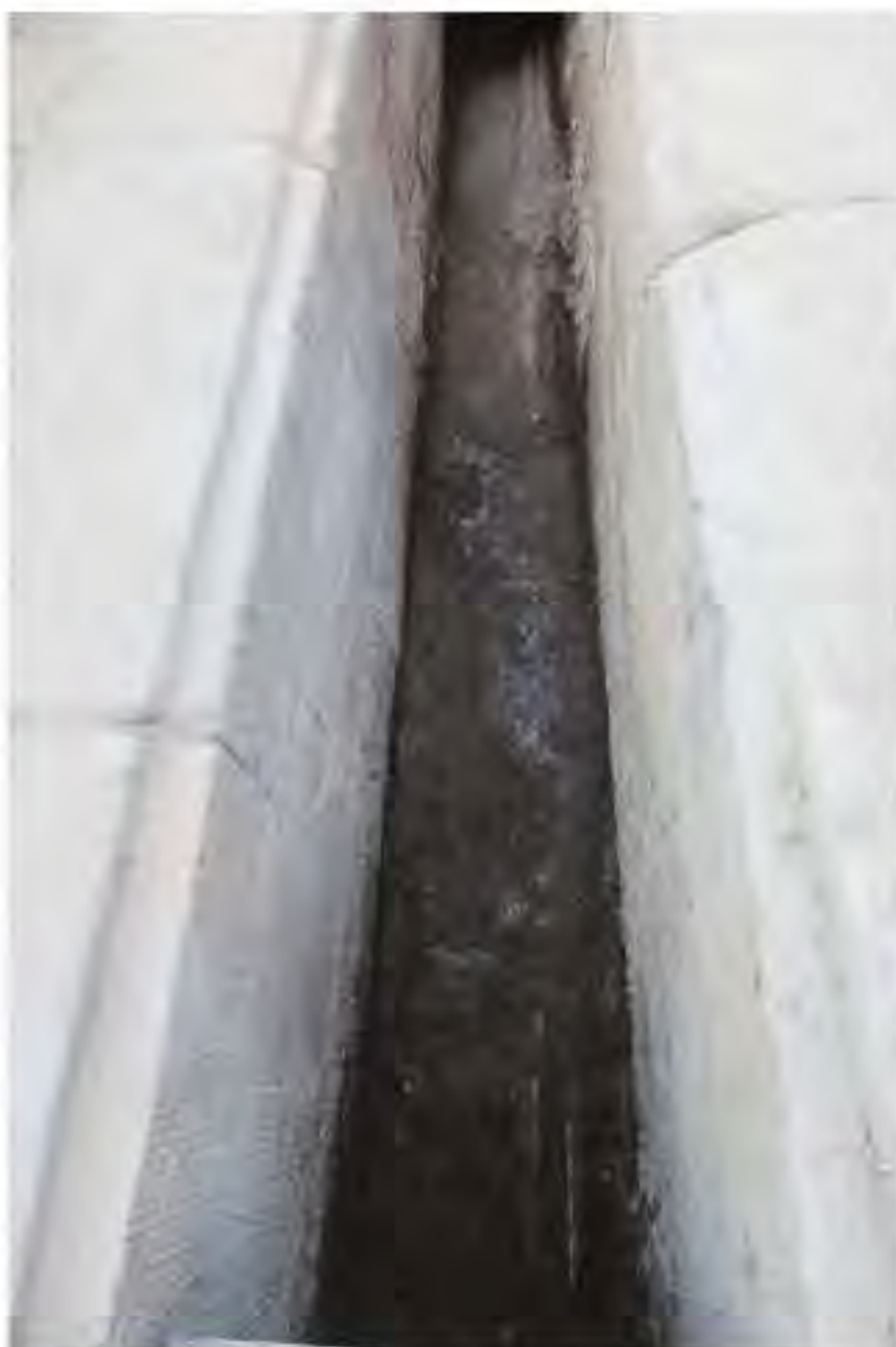
图八 三合土凹槽
