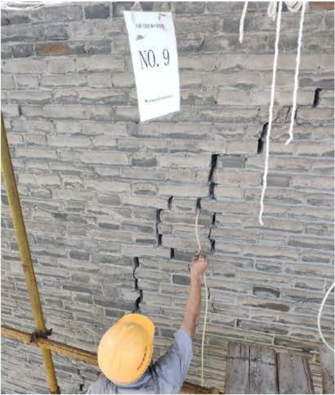
图四 气泵清理浮灰
