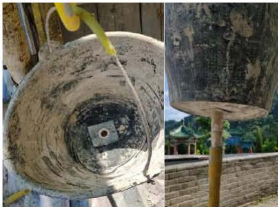
图六 自制城墙裂缝灌浆器
