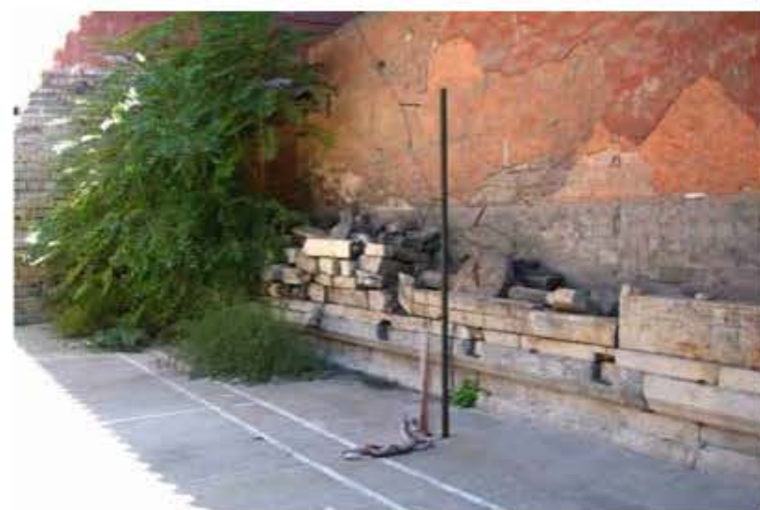
图九 西外墙台基现状
