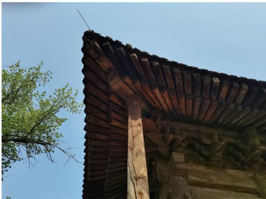
图五 大雄宝殿的转角斗拱（铺作）（拍摄方位：自西向东）
