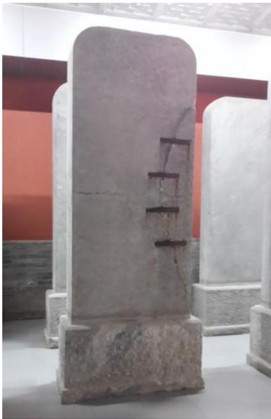
图二 铁条加固的乾隆石经《礼记》第十三碑
