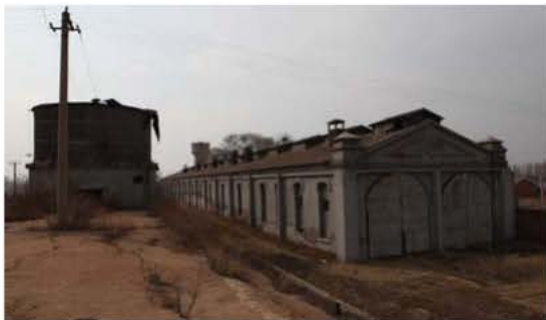
图七 康庄机车库外部现状
