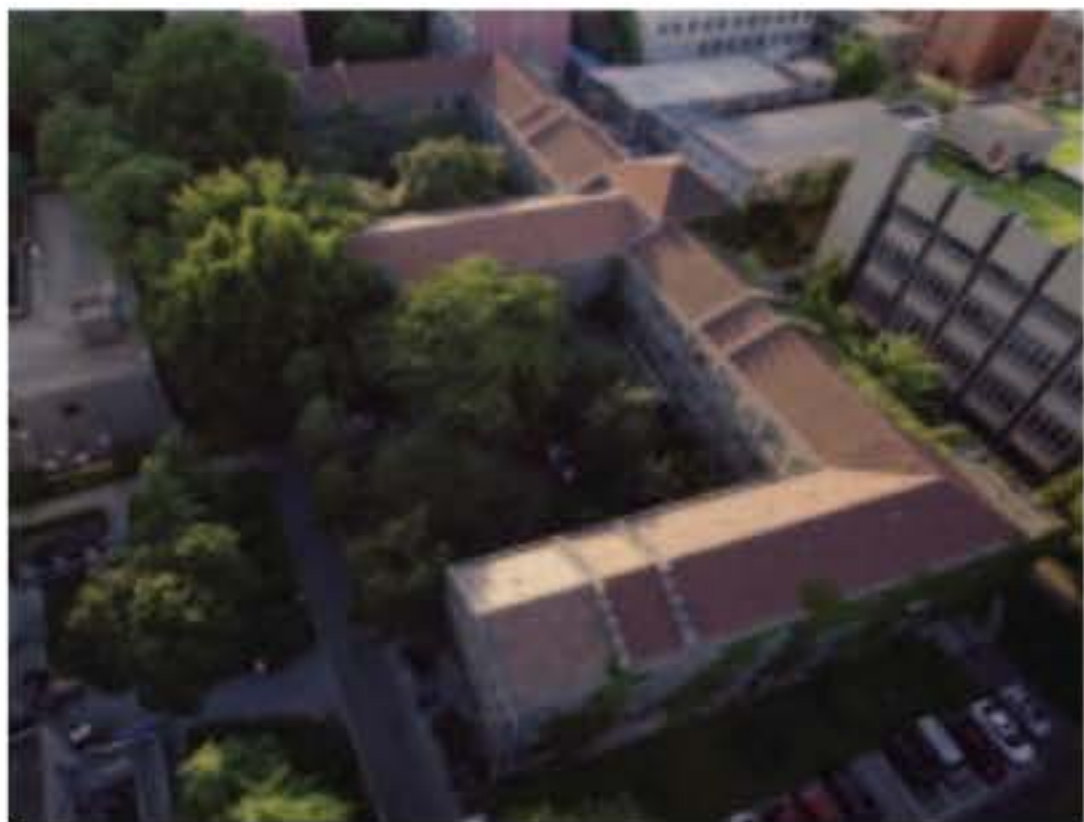
图四 圣母小昆仲会修院（山字楼）现状 ①8
