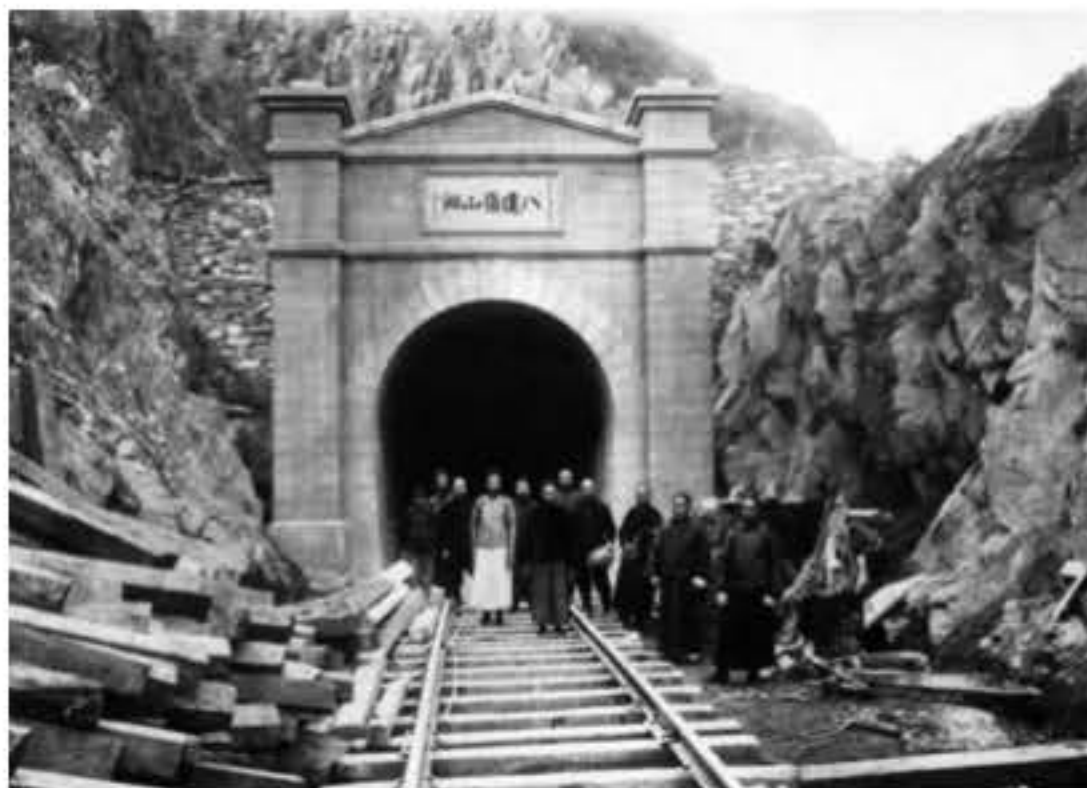
图十一 刚贯通的八达岭隧道
