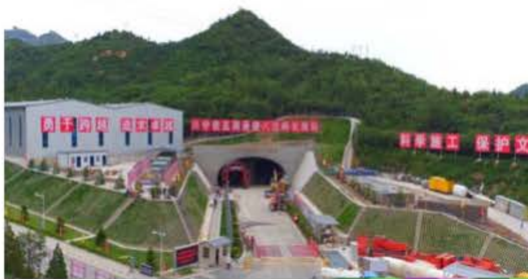
图十二 施工中的新八达岭隧道
