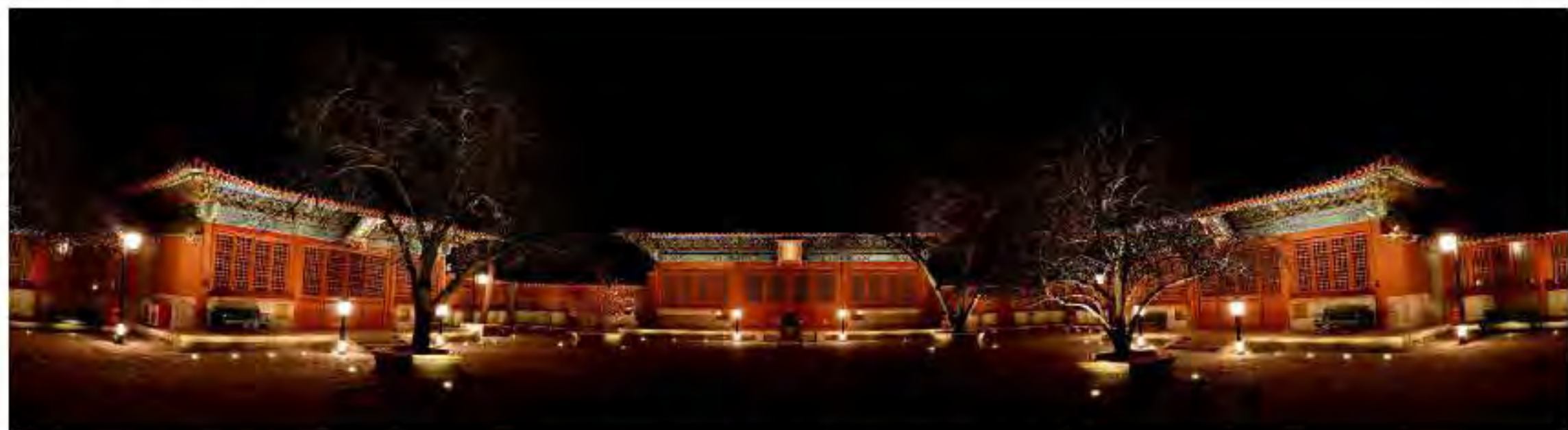
图一二 古建正立面增加LED洗墙灯的照明效果
