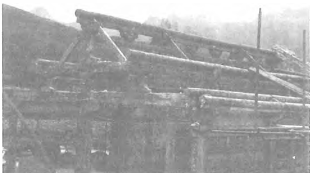
修缮前的大殿整体木构架
