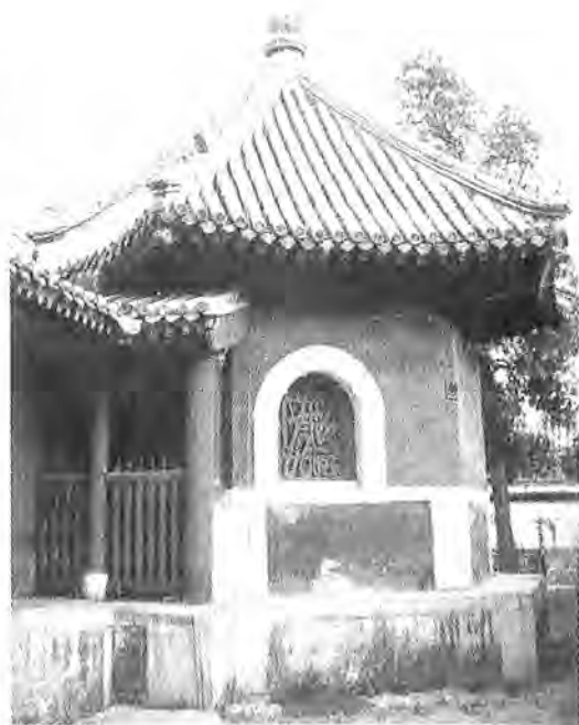
北京牛街礼拜寺礼拜大殿之内窑殿,建于辽统和十四年,即同北宋至道二年(公元996年)。是本寺今存的辽、宋古建工艺遗迹。
