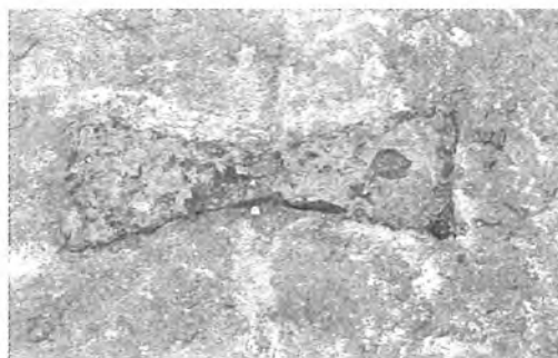
照片3 水闸海墁石上银锭锁
