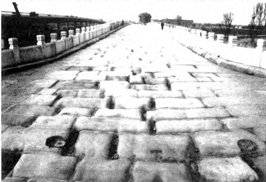
琉璃河石桥桥面
