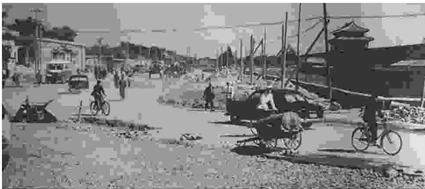
景山前街西段道路改扩建工程施工情况
