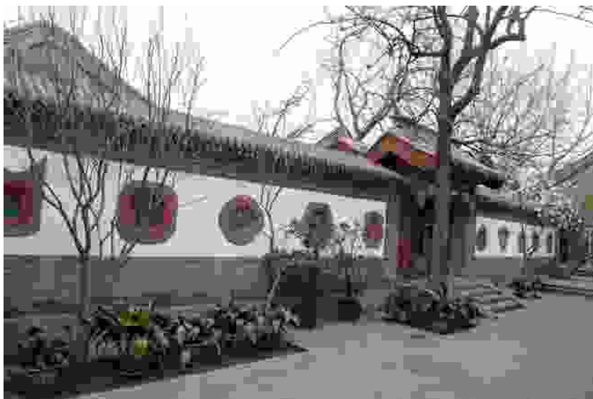
图五 西路看面墙上什锦窗
