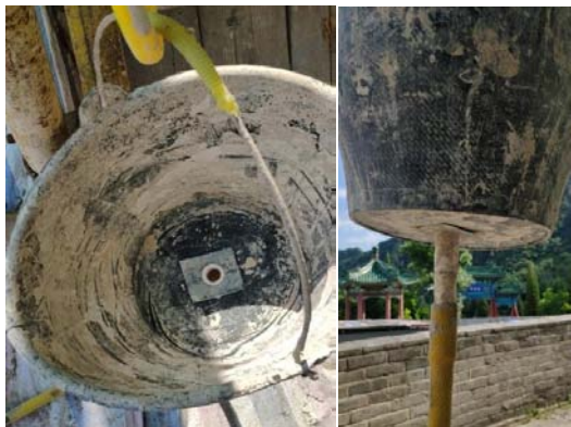
图六 自制城墙裂缝灌浆器
