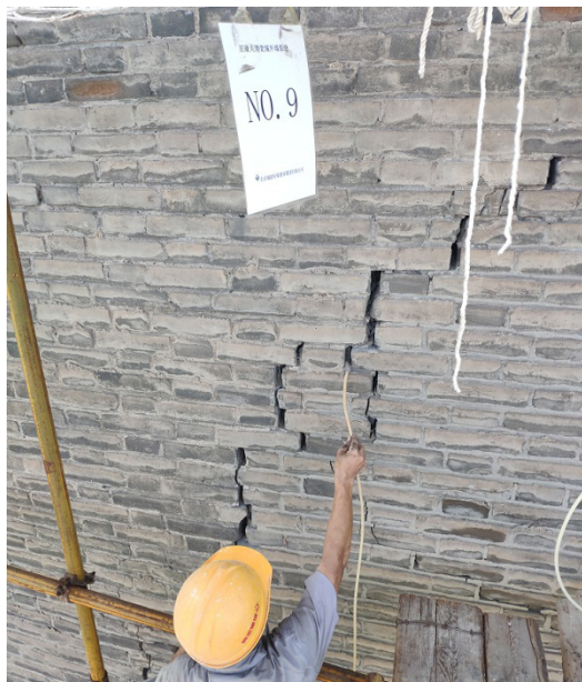
图四 气泵清理浮灰
