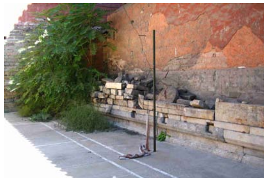
图九 西外墙台基现状
