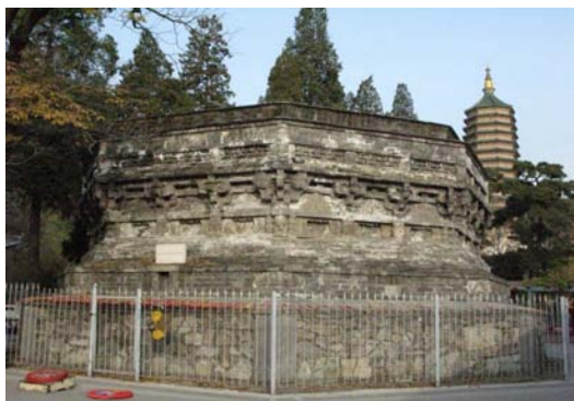
图四 灵光寺招仙塔基
