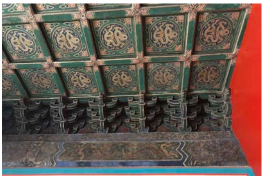
图十四 西山明间内檐隔墙板以南彩画
