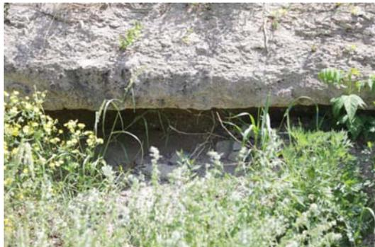
图一 东墙底部掏蚀
