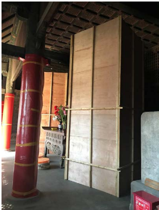
图一 施工前对如来殿内佛像进行保护
