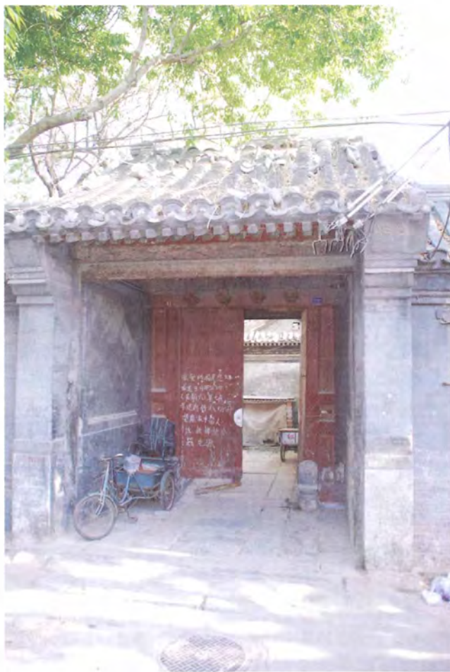
东城区炒豆胡同 69 号大门挂牌院落
