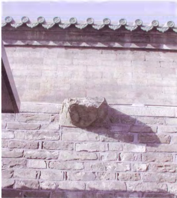
青石吐水嘴修复前
