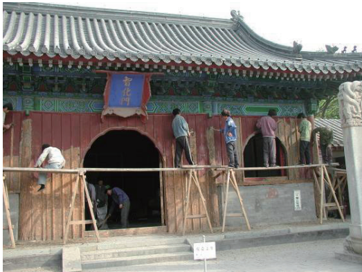
图二 2002年下架油饰工程
