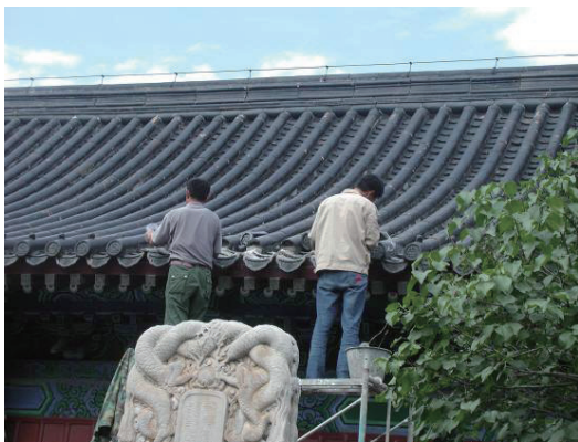
图三 2007年智化寺古建筑修缮工程，工人在补配屋面缺失的瓦件
