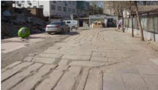
萧家河古桥闸桥面现状
