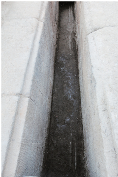
图八 三合土凹槽
