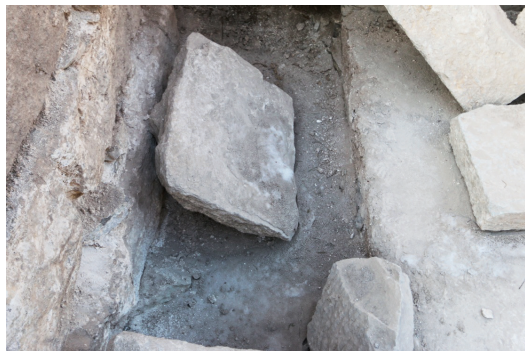
图九 金刚墙基础
