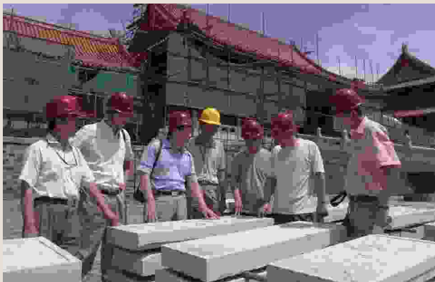
文物站站长带领监督室人员检查故宫工程施工质量
