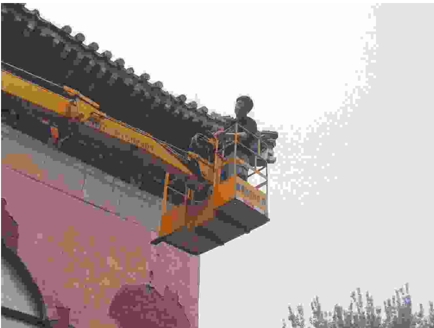
古研所职工进行古建筑结构检测
