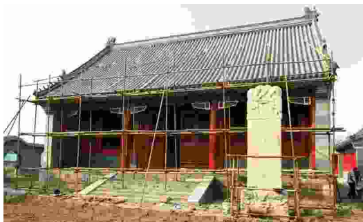
图四 修缮中的西禅寺正殿
