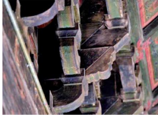
如来殿内檐柱间斗拱
